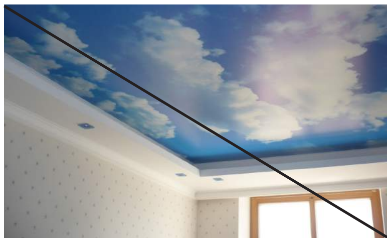
Плохо Натяжные потолки. Потолки с рисунками
